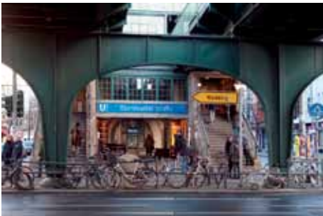
U-Bahnhof Eberswalder Straße
